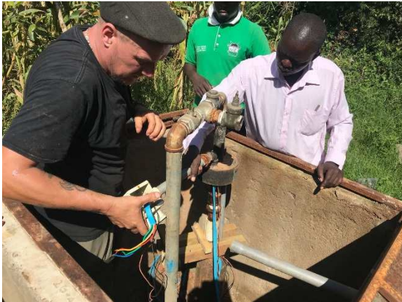
Stellan och Jerry jobbar med pumppröret.
