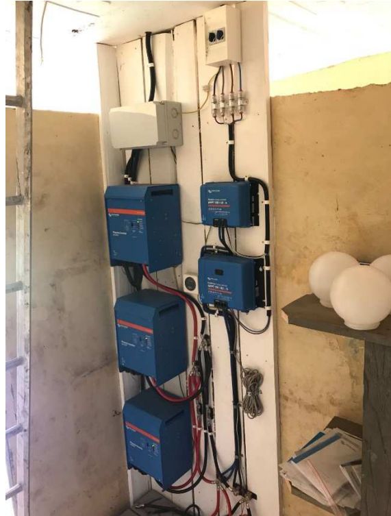
Laddare, växelriktare, batterier och övervakning
