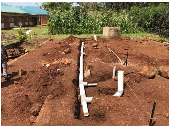
Stellan fick använda all sin övertalningsförmåga för att få sin vilja igenom. Först avlopp, sedan golv.
